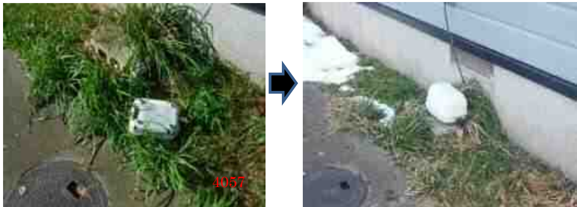
震災直後のブロワ落下 と 復旧後
