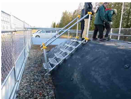
階段の設置 (手すり有り)
