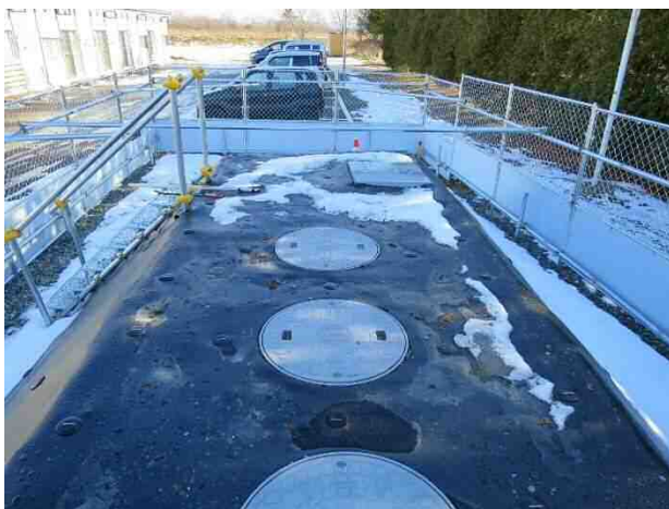
浄化槽の上部及び周辺に積雪が見られる (平成 30 年 12 月 18 日撮影)
