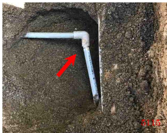
空気配管の切断
