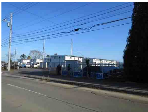
仮設住宅と浄化槽設置状況
