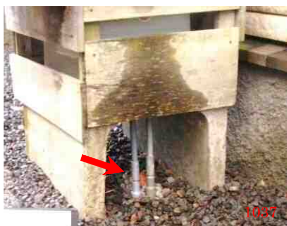
空気配管修理後
