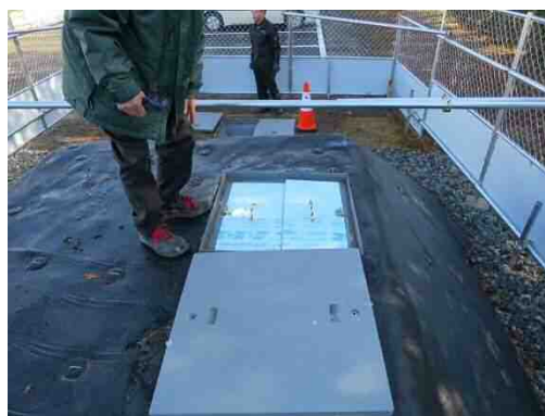
計量槽をウレタンフォームにより保温
