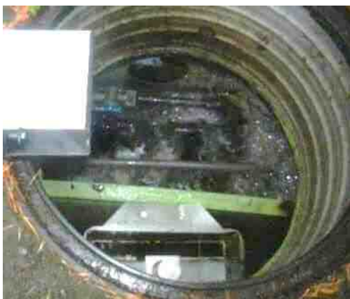
接触曝気室の水位低下
