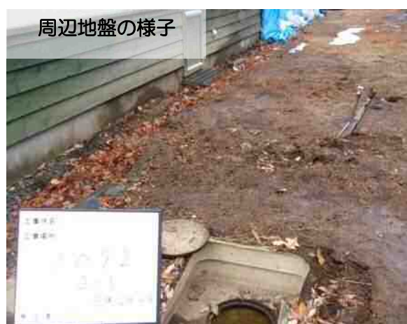
周辺地盤の様子
