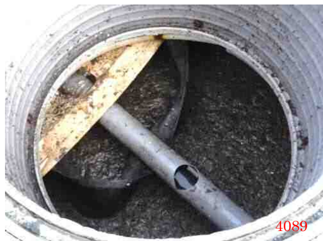
隔壁・移流バツフル変形
