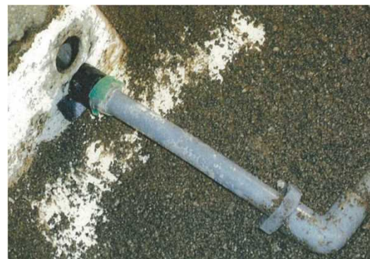
故障した配管（改築前）
